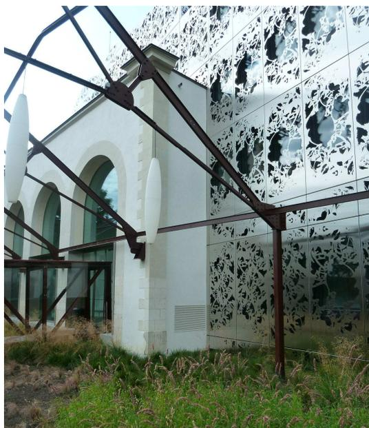
La consommation conventionnelle d'énergie pour le chauffage, le refroidissement, la production d'eau chaude et les auxiliaires (ventilation et pompe) a été estimée à 62 KW/m<sup>2</sup>/an, soit presque un niveau BBC. Les fenêtres posées sont oscillo-battantes, en triple vitrages, de 50kg, et issues du recyclage de pare-brise locaux. 250 m<sup>2</sup> de panneaux photovoltaïques ont été installés sur le toit.
