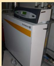
La chaudière gaz à condensation (haut rendement) assure le chauffage de tous les logements et le complément pour la production d'eau chaude sanitaire.
