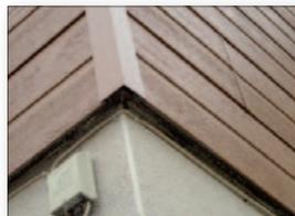
Une lame d'air ventilée (entrées d'air en rive basse et sorties d'air en rive haute) est indispensable pour évacuer l'humidité et les condensations éventuelles.
