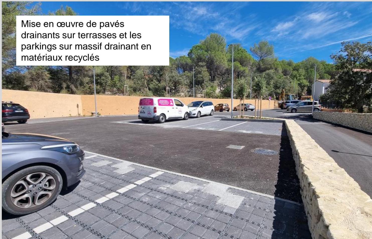
Mise en œuvre de pavés drainants sur terrasses et les parkings sur massif drainant en matériaux recyclés
