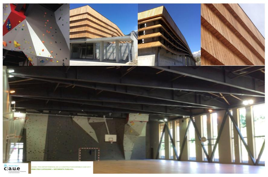
Aspect architectural et technique: L'enveloppe extérieure en vêture de bois de mélèze, épouse le mouvement de la toiture et des façades, et s'ouvre, au gré des besoins, pour laisser filtrer la lumière naturelle et cadrer les vues sur le paysage.
