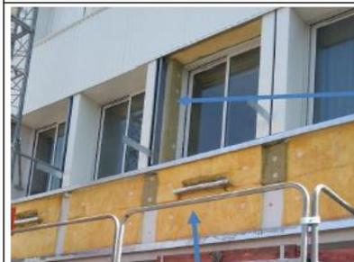
Isolant laine de roche R=1,1 isolation des linteaux, tableaux. Conforme au CCTP. Document fournis
