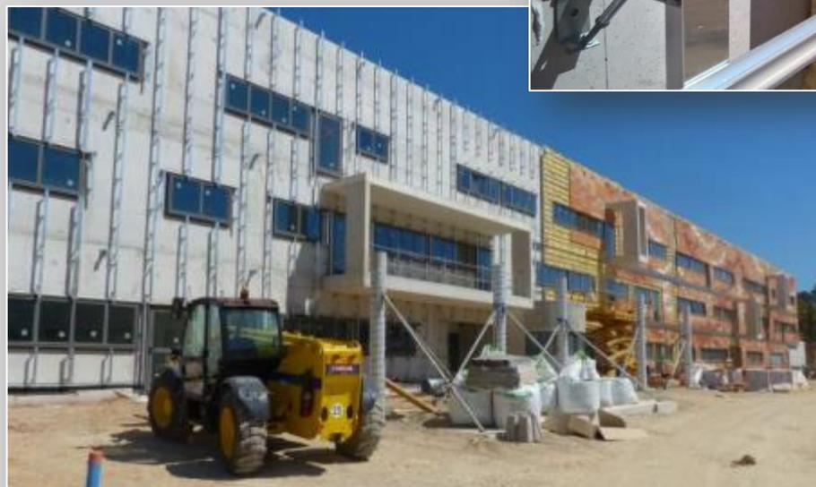
Isolation thermique par l'extérieur sous bardage terre cuite ou sous enduit
