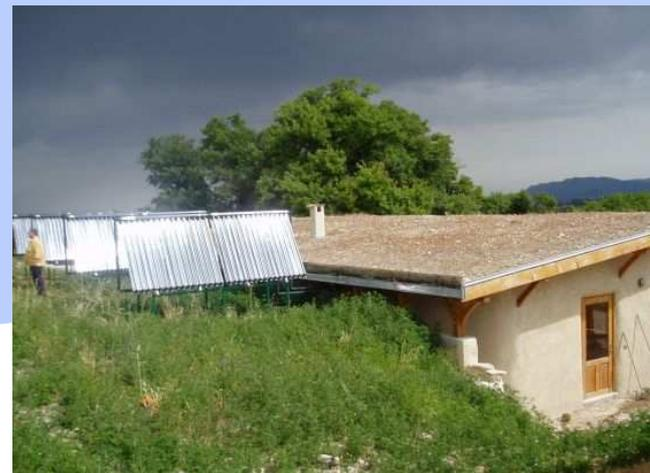
Panneaux solaires posés à même le sol, derrière les deux bâtiments d'hébergement, pour le chauffage et l'ECS
