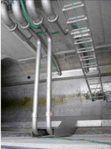
La Liaison entre les échangeurs, disposés dans le collecteur et la pompe à chaleur, en chaufferie effectué a l'aide d'un réseau caloporteur contenant de l'eau (éventuellement glycolée)
