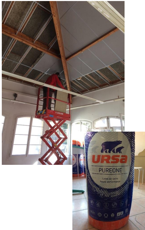
Isolation toiture salle de restauration + pose de faux-plafonds acoustiques
