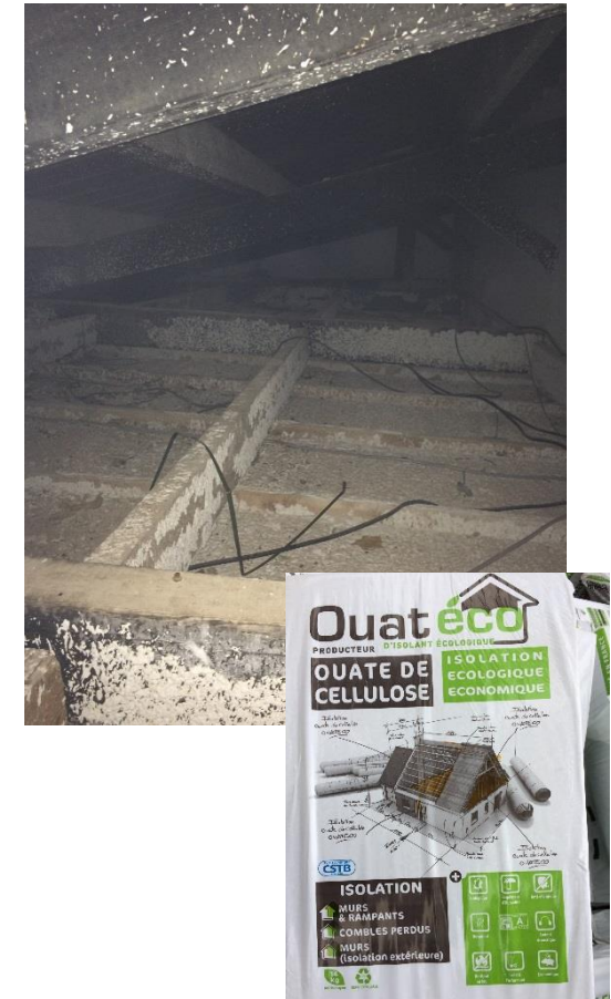
Isolation des combles en ouate de cellulose
