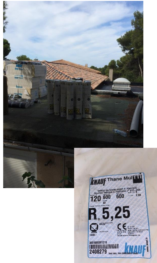
Isolation des toitures terrasse + étanchéité
