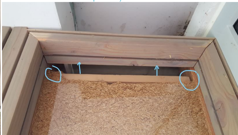
Témoin du tassement de la balle (visite de rongeur par le haut du cadre suspectée)
