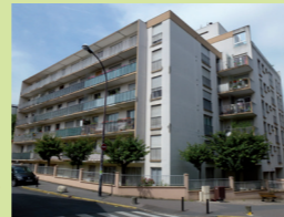
Etat initial et travaux en cours (décembre 2015) - Source MVE
