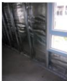
Pare-vapeur assurant l'étanchéité à l'air - à ne pas percer.
