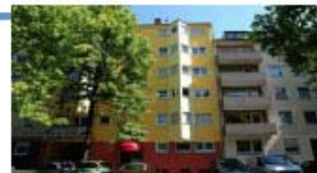
Logements collectifs, Nuremberg, Allemagne
