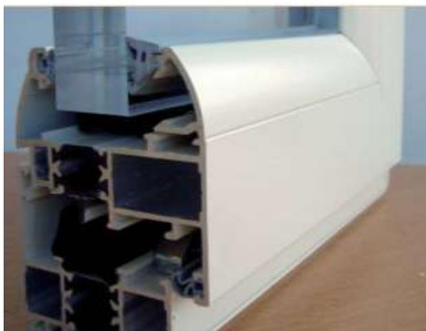
Figure 1 - Rupture de pont thermique par barrette PA sur ouvrant et dormant (Source CSTB)
