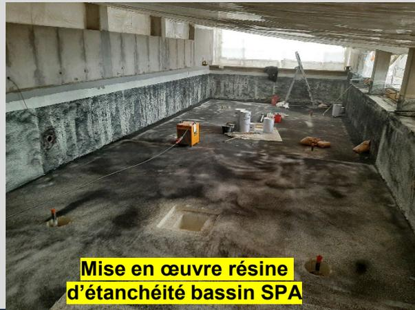
Mise en œuvre résine d'étanchéité bassin SPA
