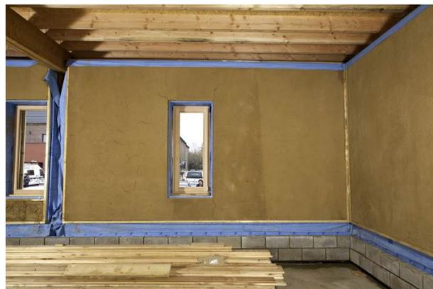
Les parois préfabriquées en atelier avec leur enduit de corps sont posées sur chantier. Seul l'enduit de finition est appliqué sur site.
