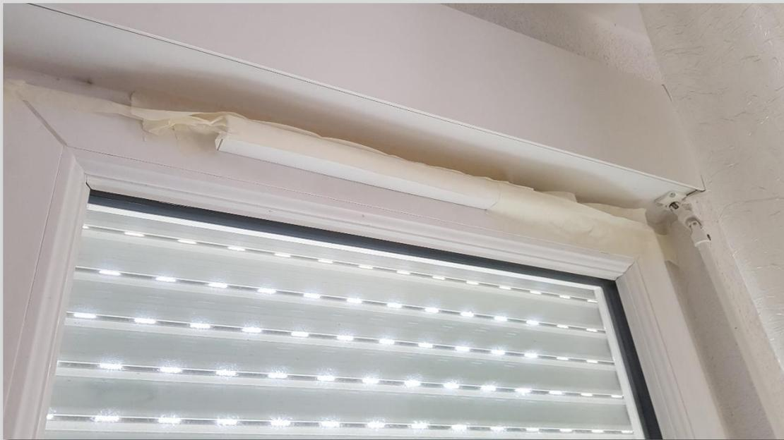
Mauvaise usage constaté: bouche d'amené d'air bouchée, car la personne était gênée par les courant d'air généré entre la prise d'air sur la menuiserie extérieure et celle sur le mur perpendiculaire. L'association API Provence veille à corriger ce genre de mauvaise avec pédagogie pour s'assurer de la bonne évolution sanitaire du logement.
