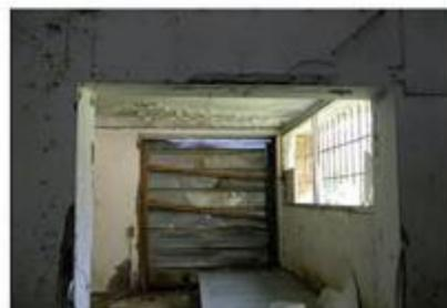
Éclatement des bétons du linteau et des piédroits probablement liés à un choc mécanique
