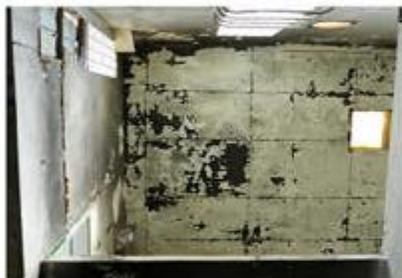
Pénétrations et désordres liés à l'eau sous la toiture terrasse haute. Ouvertures zénithales non bouchées
