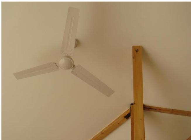
Le brasseur d'air sert essentiellement à la déstratification de l'air chaud en hiver.
