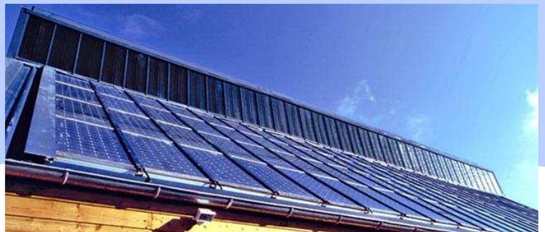
Le choix du solaire s'est imposé comme une évidence pour la production d'énergie du bâtiment, dans une des régions les plus ensoleillées de France. Les capteurs photovoltaïques sont parfaitement intégrés dans la toiture du bâtiment de stockage, orientés au sud. S'étendant sur une surface de 100 m<sup>2</sup>, cette installation était, à l'époque de la construction du bâtiment, la plus grosse puissance jamais installée en France en toiture intégrée.
