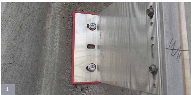
1 : Mise en place de rupteurs de ponts thermiques entre l'équerre et le mur permettant de réduire les déperditions d'énergie aux seuls passages des chevilles de fixation qui traversent les rupteurs.
