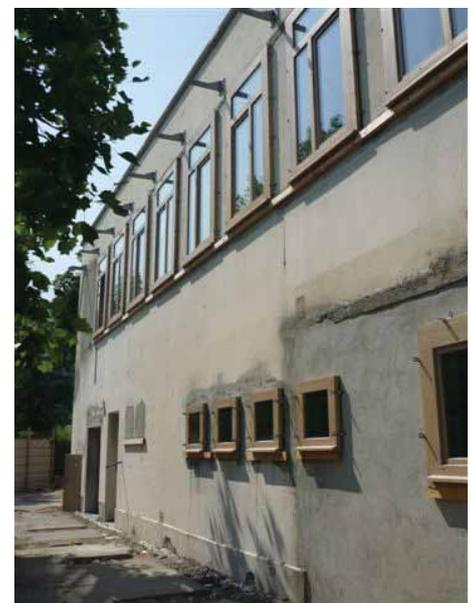
Mise en place des menuiseries bois pour la zone avec bardage bois (source : TANDEM Architectes)
