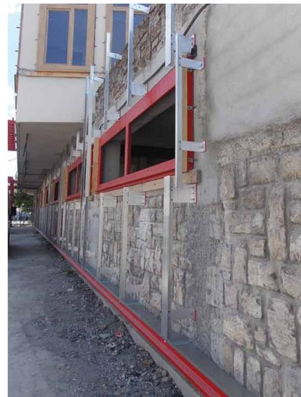
Zones avec bardage métallique : ossature métallique se fixant ponctuellement contre des rupteurs de ponts thermiques
