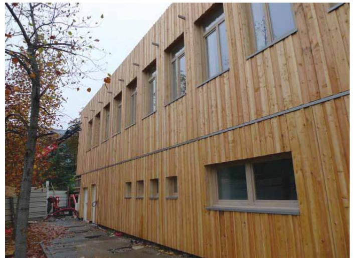
Mise en place du bardage bois sur l'ossature bois + pare-pluie (source : TANDEM Architectes)
