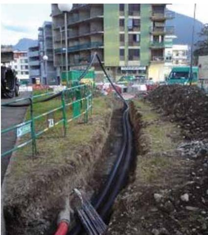
Travaux de mise en place des canalisations du réseau de chaleur (source CETE)
