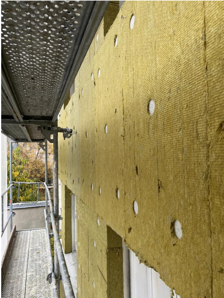
Mise en œuvre de l'isolant
