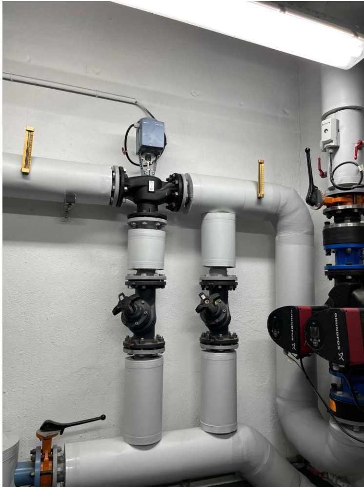
Calorifugeage des réseaux
