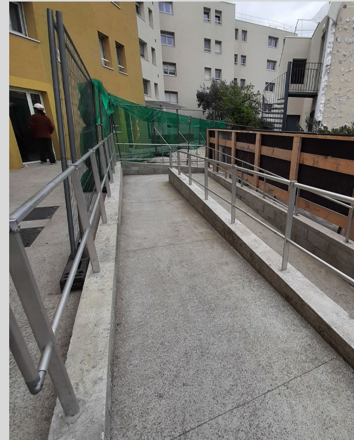
Réemploi des garde-corps de toiture en garde-corps rampe d'accès
