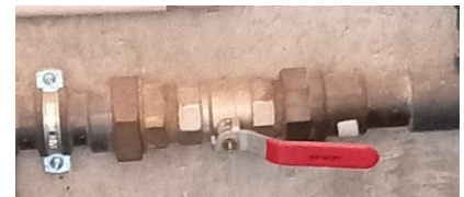
Figure 28 Photographie d'une vanne d'isolement, dite à quart de tour
