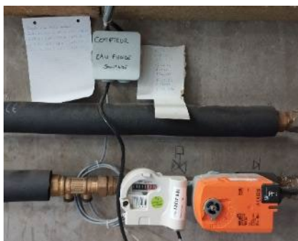
Figure 47 Compteur d'appoint en eau potable et relevés manuels conservés sur papier à côté
