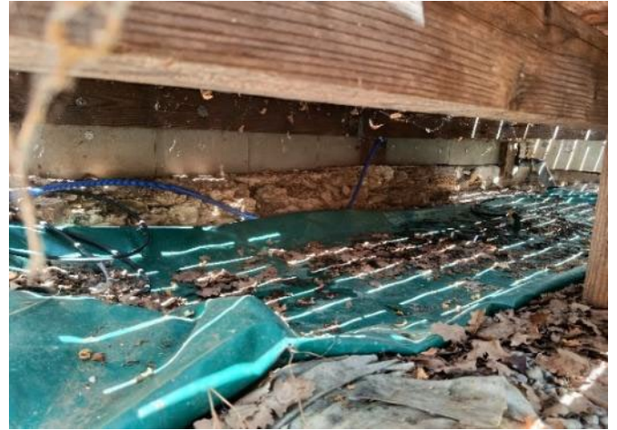
Figure 89 : dépôt végétal formé sur une cuve souple
