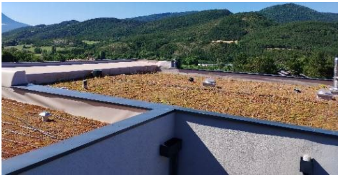
Figure 39 : Photographie d'une partie des toitures végétalisées avec présence des canaux d'irrigation
