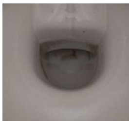
Figure 70 : dépôts visibles dans l'eau du sanitaire
