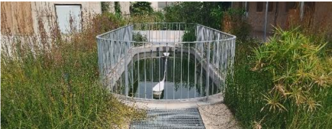
Figure 59 : Bassin d'algues et du filtre hélophyte périphérique
