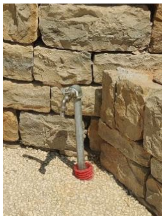
Figure 65 Photographie du robinet de puisage alimenté par les eaux de pluie, accessible à tous, sans signalétique
