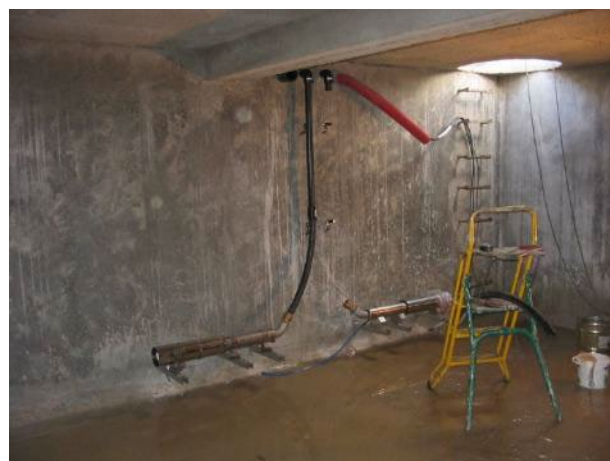
Figure 77 : Photographie de l'intérieur du bassin sud, des pompes immergées en cours de pose ainsi que du regard d'accès. Image appartenant à la MOA.
