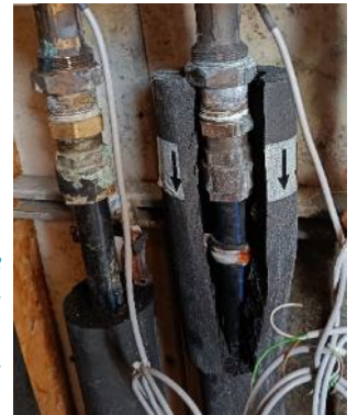
Figure 68 Photographie de 2 tuyaux PEHD à bande bleue, pour l'alimentation en eau potable, avec la bande pas ou peu visible sous l'isolation
