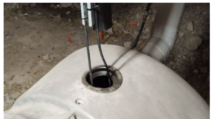
Figure 45 : Photographie de l'orifice ouvert sur la partie supérieure de la cuve de stockage des eaux de pluie
