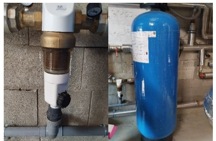
Figure 57 - Filtre à maille (à gauche) et du filtre à sable (à droite)
