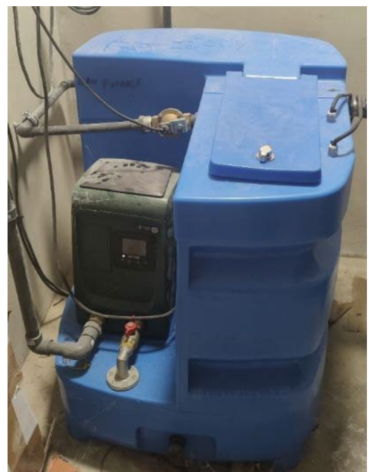
Figure 29 Exemple de système gestionnaire d'eau de pluie disposant d'un système de surpression (boîtier foncé à gauche)
