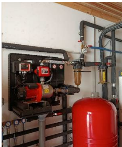
Figure 51 Système manufacturé gestionnaire et du vase d'expansion
