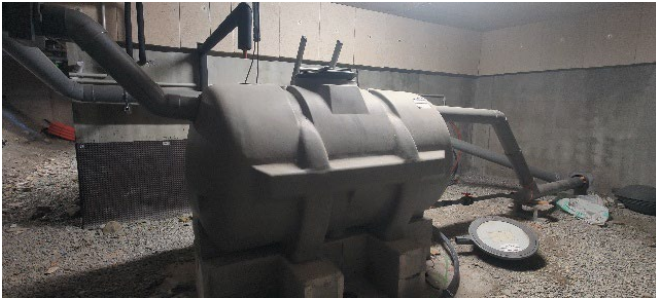
Figure 19 Cuve rigide en PEHD de 2 m 3
