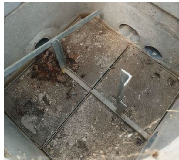
Figure 69 Grille permettant une première filtration grossière du flux entrant dans la cuve
