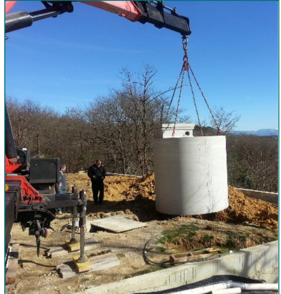
Figure 15 Installation d'une citerne en béton de 10 m 3 de récupération d'eaux de pluie (Source : Stockao)
