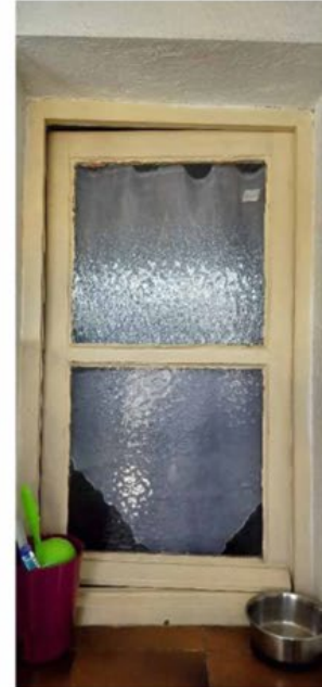
Ventilation WC par fenêtre donnant sur le séchoir
