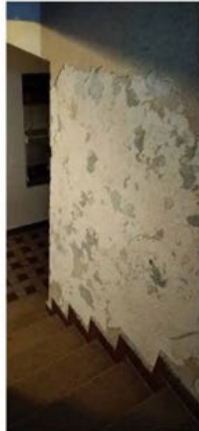
Les murs d'échiffre sont délabrés par endroit
