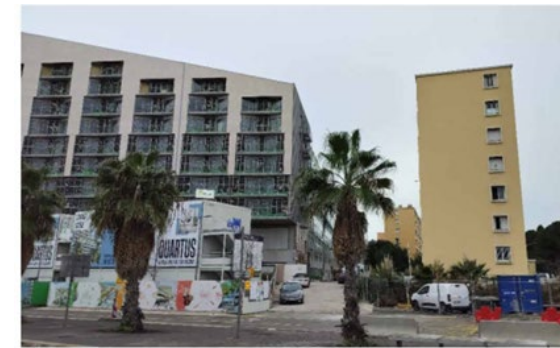
L'Avant-Scène, chantier arrêté, et le Bâtiment 1 de la Résidence les Sagnes
