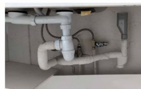
Reprises des attentes et évacuations sous évier
