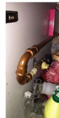
Robinets du gaz dans sous plan de travail
