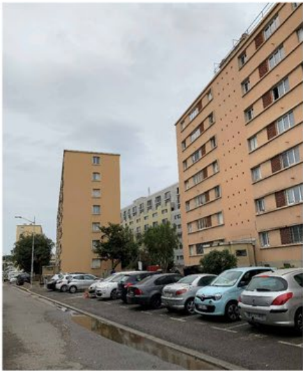
1 2 3 Les trois bâtiments en enfilade
