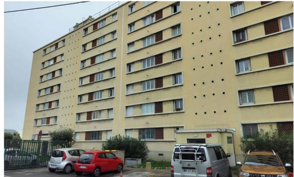
Les cadres maçonnés regroupent les fenêtres d'un même appartement avec les claustras en briques creuses. Les pavés de verre éclairent les cages d'escalier.
