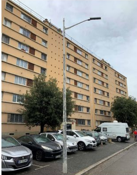
Les cadres maçonnés regroupent les fenêtres d'un même appartement avec les claustras en briques creuses. Les pavés de verre éclairent les cages d'escalier.
