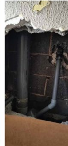
Interventions sur réseaux non abouties en gaine derrière cuisine
