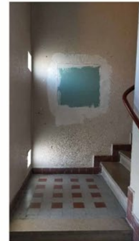
Interventions sur réseaux non abouties en gaine derrière cuisine
