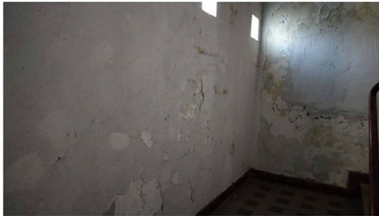
Les murs d'échiffre sont délabrés par endroit
