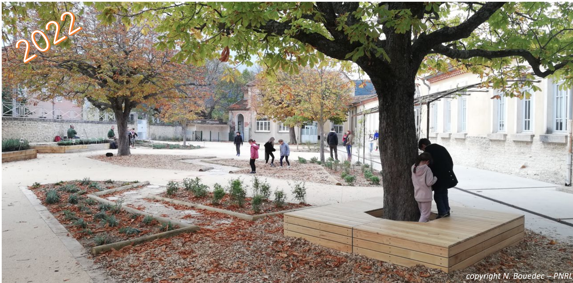
Travaux de désimperméabilisation / revégétalisation de la cour
