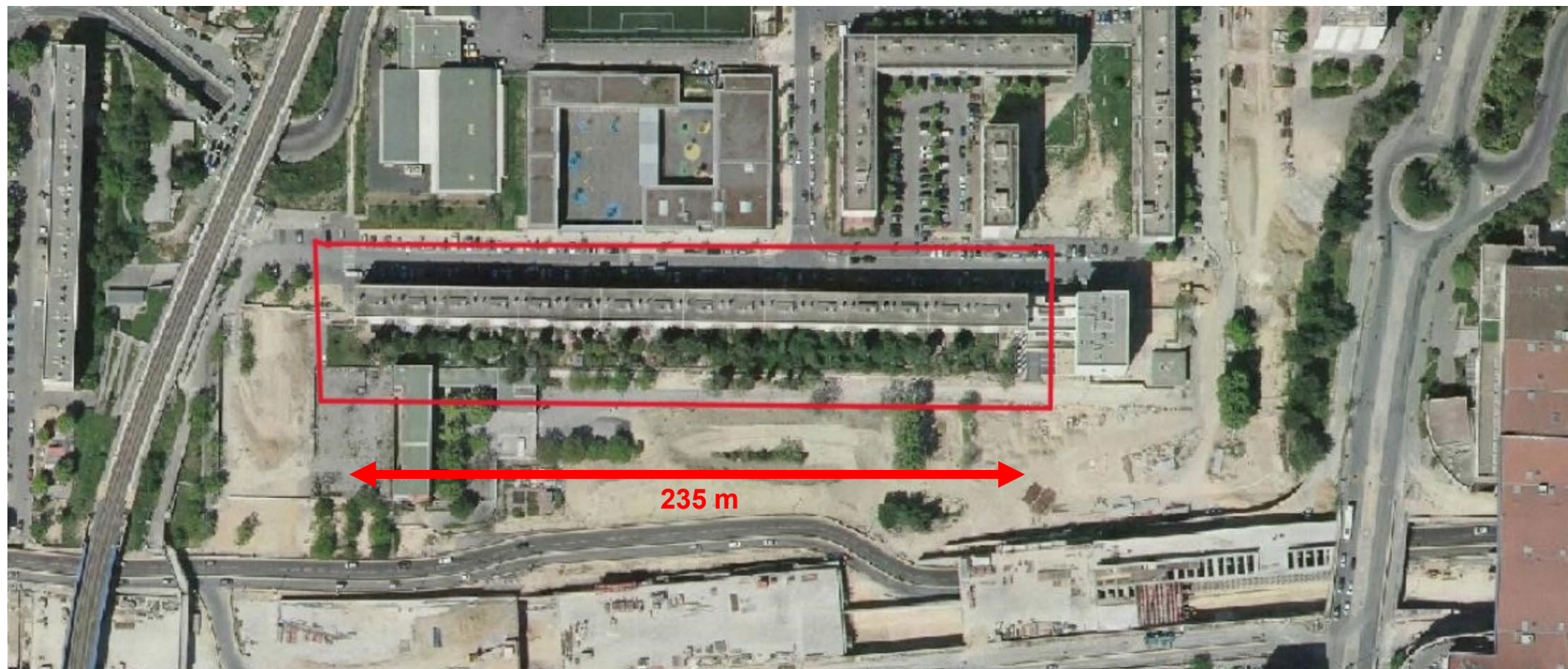
Vue aérienne quartier de la Busserine bâtiment J
