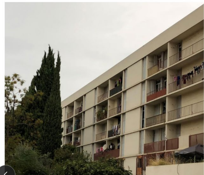
Façade sud - existant
