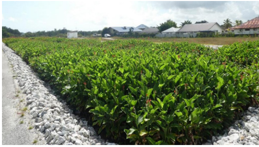
Systemes d'assainissement collectifs et/ou semi-collectifs par bassins filtrants sur l'OIN Margot. Crédit photo : Franck Brasselet et Frédéric Pujol
