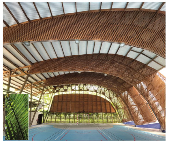
Hall sportif de Papaïchton, architecte : JAG, lauréat du prix Climats chauds des Green Solutions Awards France 2022-2023
