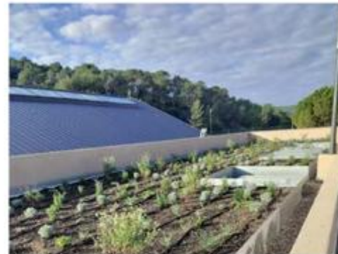
Toiture terrasse végétalisée
