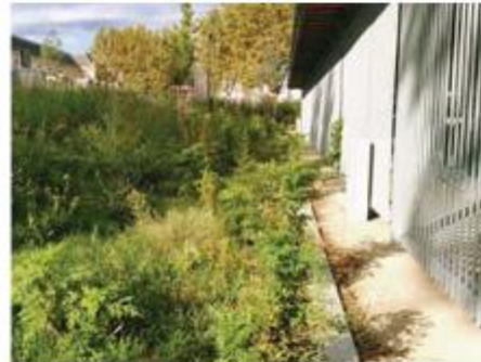
Tranchée d'infiltration en point bas
