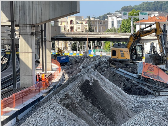
24/05/2023 dépose des anciens rails et évacuation terre
