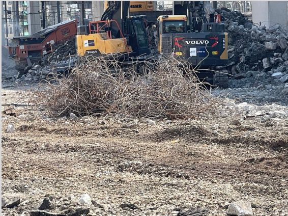
24/05/2023 tri et valorisation des matériaux de démolition
