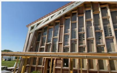
**26 juillet 2021** – La Ferme des possibles se situe à Stains, en Seine-Saint-Denis. L'architecte du projet, Frédéric Denise, a conçu un bâtiment bioclimatique, à la fois sobre en énergie et en ressources. Isolation en paille, enduit en terre crue, solutions high tech (le système de refroidissement utilisé permet de chauffer le bâtiment), etc. : le bâtiment se pose comme véritable démonstrateur de l'économie circulaire et de la conception biosourcée.
