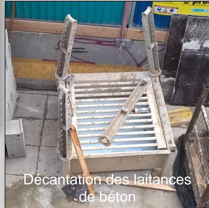
Décantation des laitances de béton
