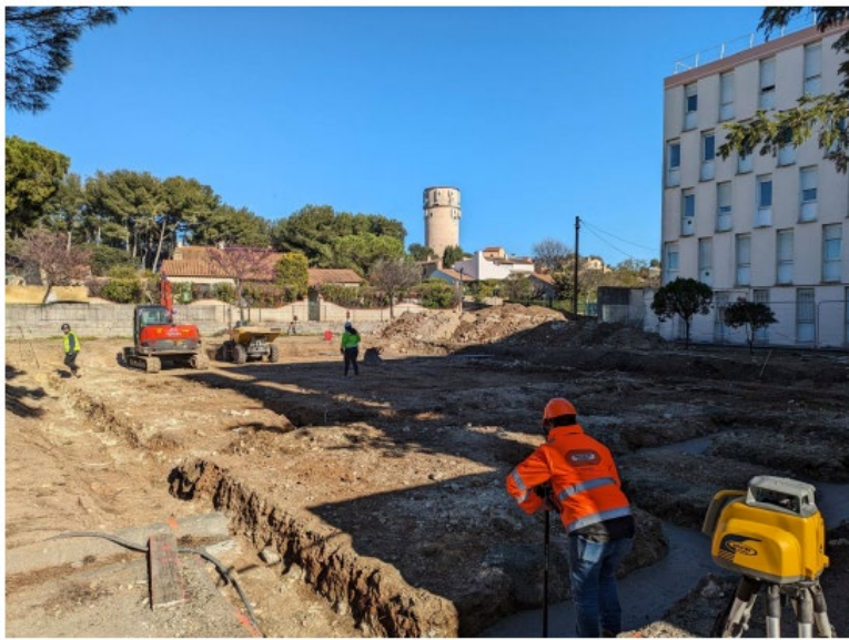
Début des fondations de la PF
