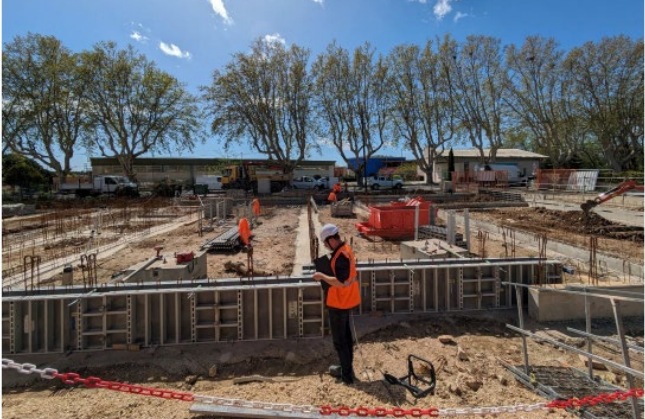
Début des fondations et réseaux sous-dallage de la RS
