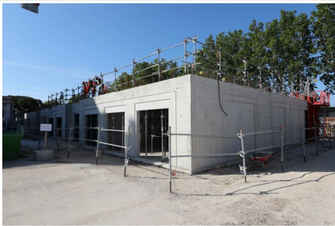
Avancement voiles RDC et plancher bas de la RS
