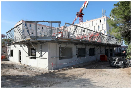
Avancement voiles RDC et plancher haut de la PF
