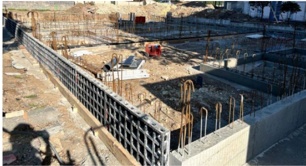
Fondations de la PF
