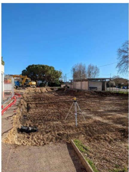
Terrassement de la RS
