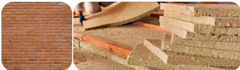
**Façades** : RDC en béton bas carbone, puis brique monomur (Fabtherm) avec ITI biosourcé
