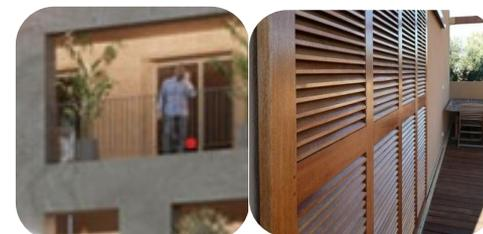
**Autres éléments** : fenêtre PVC recyclé avec volets bois persiennés
