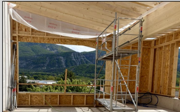
Façades MOB en cours
