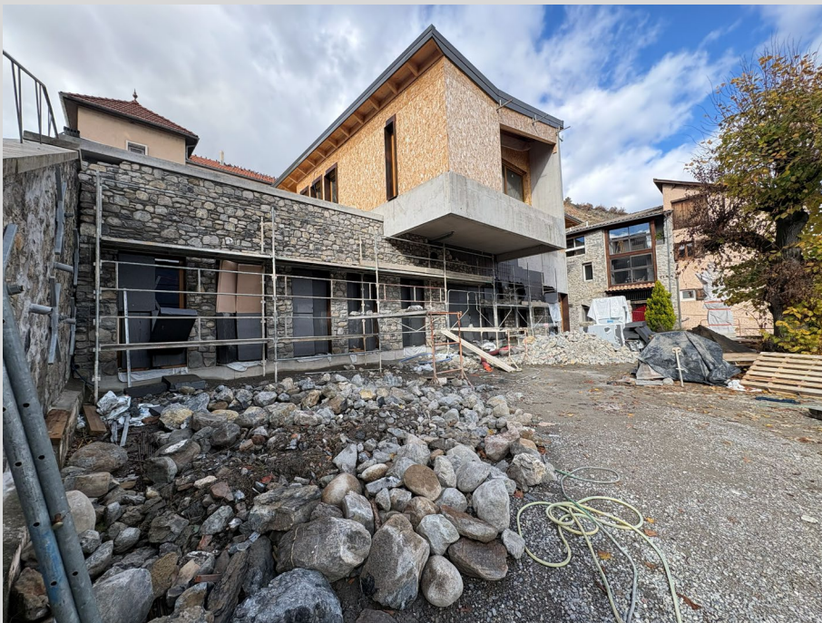
Un chantier propre
