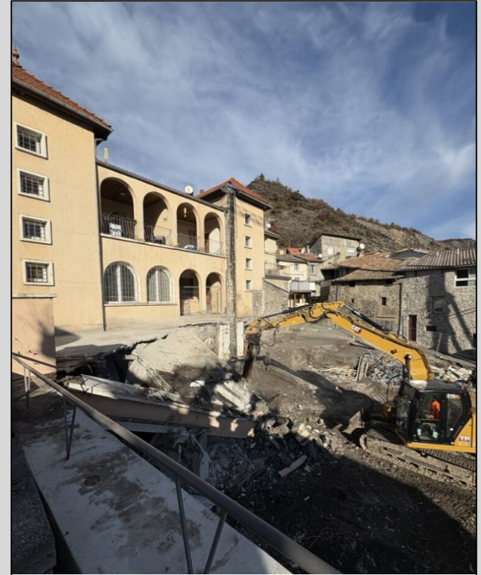
Démolition de l'existant
