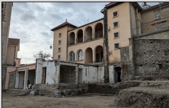
Démolition de l'existant
