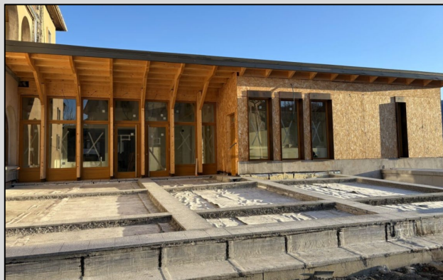
Prépa avant revêtement final
