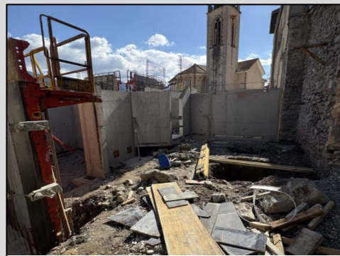
Démolition de l'existant
