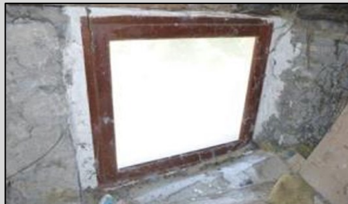
Joint de mastic de vitrage, petites fenêtres bois
