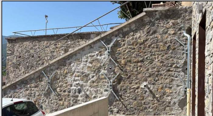
Renforcement mur de soutènement
