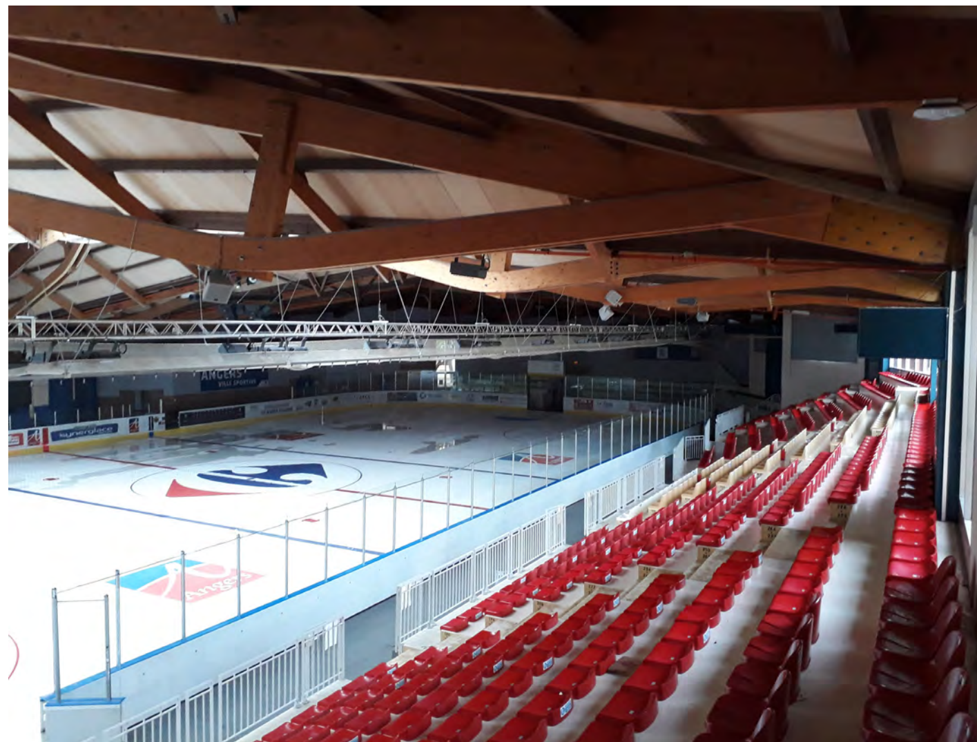
Poutres cintrées Patinoire du Haras / Ville d'Angers
