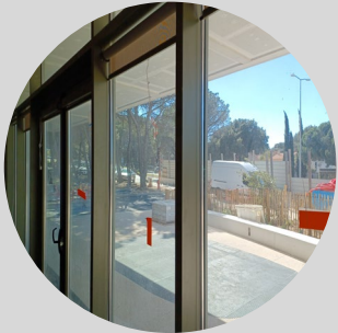
Menuiseries Alu Contrôle solaire est/ ouest/ sud
