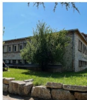
6 - Prunus - Bon état proche de la façade
