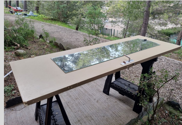
et détalonnage des portes intérieures pour la ventilation
