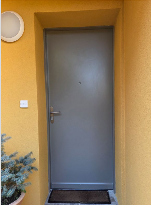
Remplacement des portes palières U_p = 1,6 \text{ W/m}^2 \cdot \text{°K}
