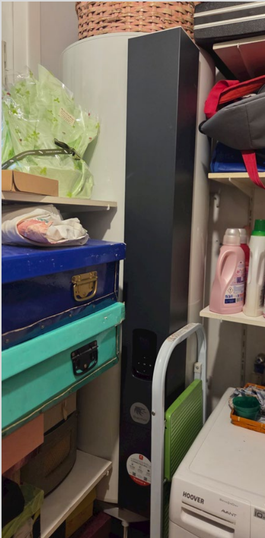
Ballon thermodynamique Thermor dans les celliers
