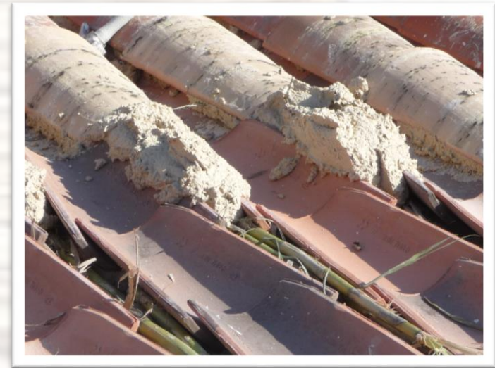
Ventilation et support tuile de couvert
