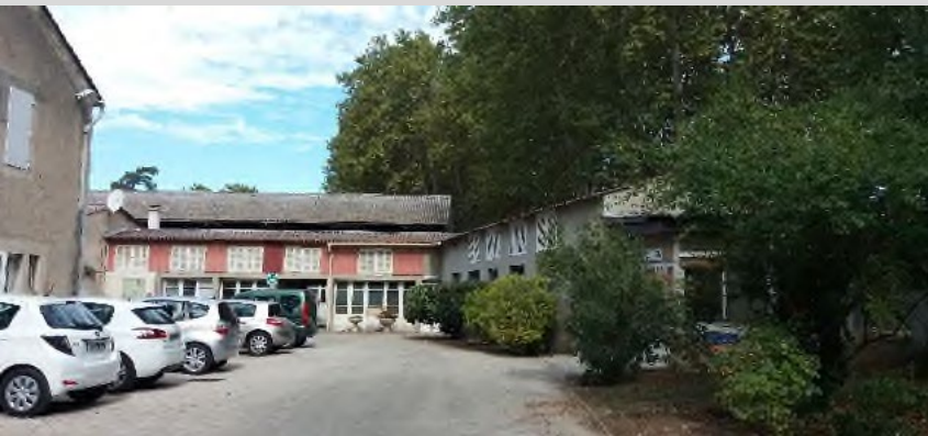
1. Bâtiment 020 – A démolir
