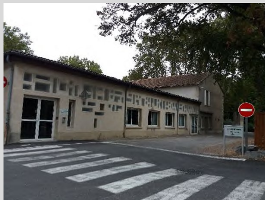
2. Bâtiment 004 (à démolir)
