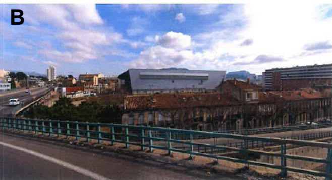
Vue depuis la bretelle d'autoroute vers le site
