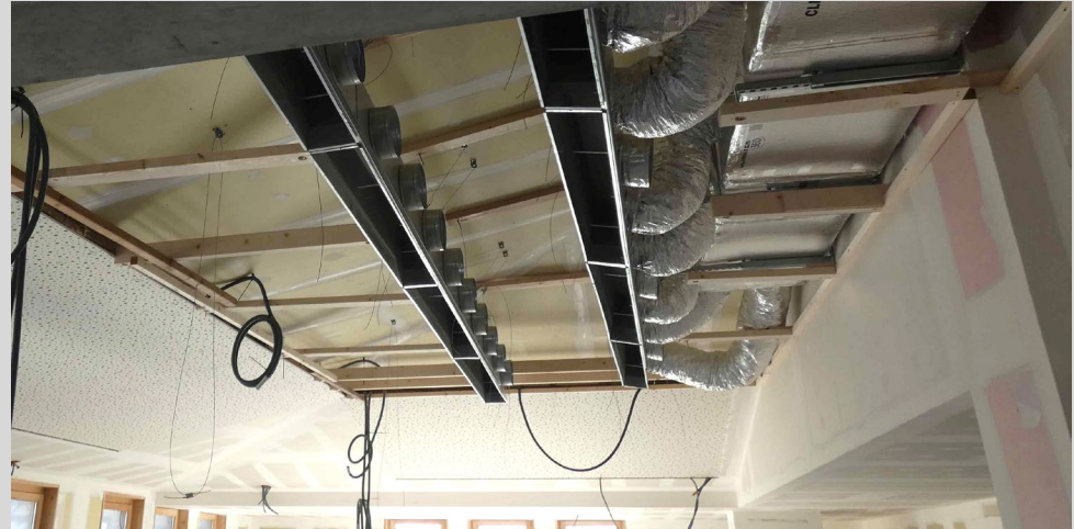
Gainage ventilation et attente électrique
