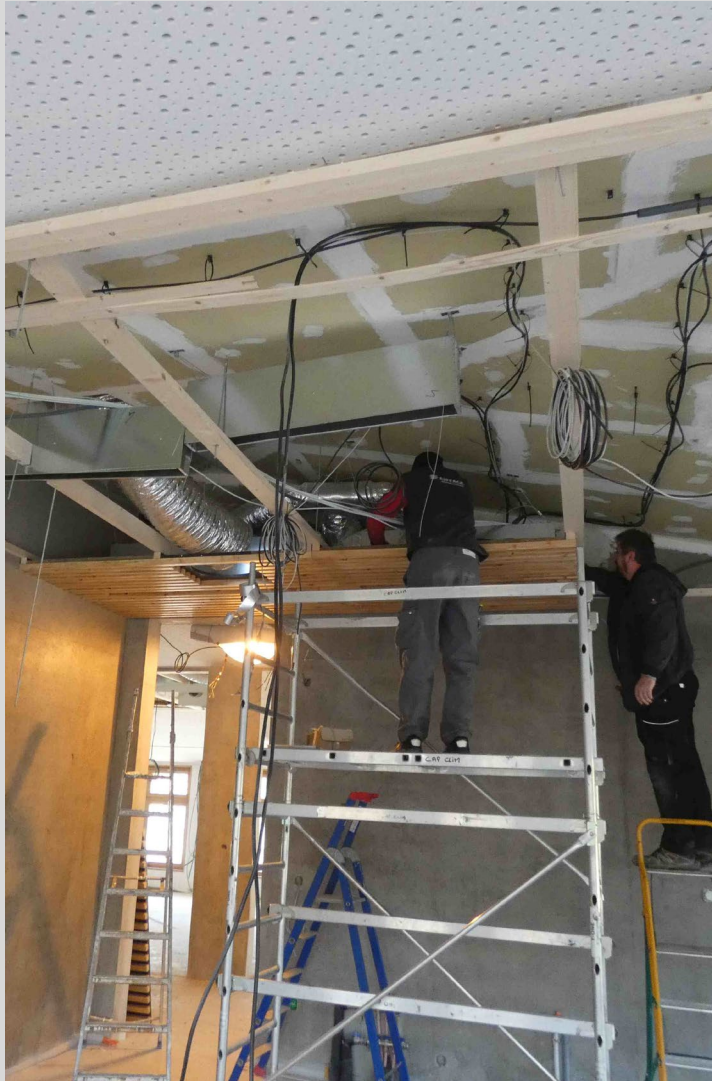
Fixation des panneaux sur l'ossature
