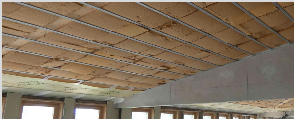
Plaquage des plaques de plâtre BA18 à travers les tiges filetées fixées sur la charpente
