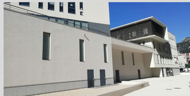
Façade Est pas endommagée par le chantier à proximité
