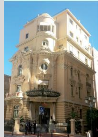
Bâtiment avant travaux
