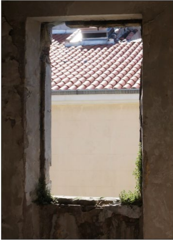
Baie avant travaux
