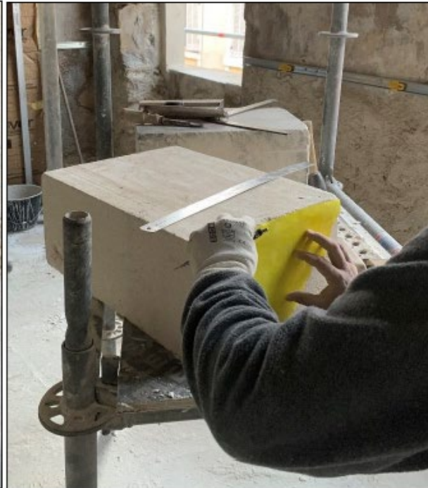
Taille de la nouvelle pierre en remplacement
