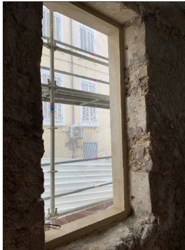
Réalisation de feuillures sur les anciennes baies
