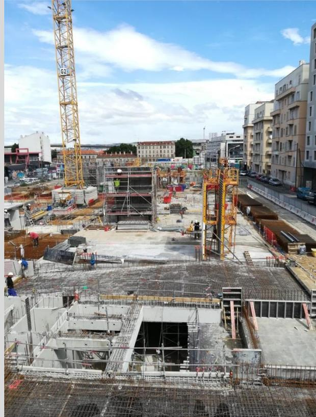
Réalisation du Plancher Haut du R-1 (suite) et préparation des élévations du RDC
