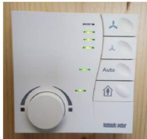
réglage de la vitesse de ventilateur : laissez le mode automatique, la vitesse sera adaptée en fonction du besoin. Une fois la température de consigne atteinte le ventilateur réduira sa vitesse et deviendra inaudible.
