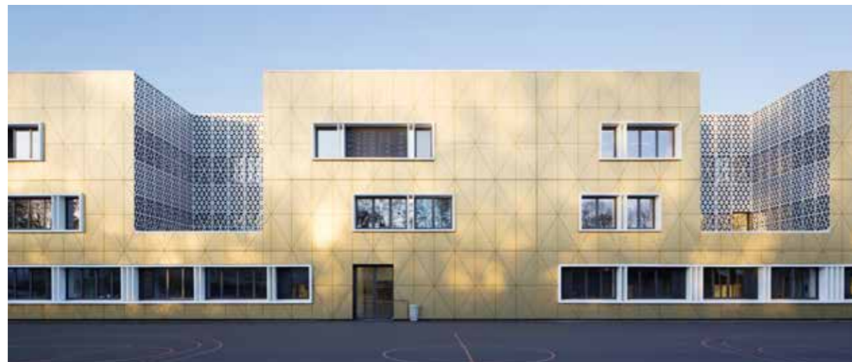
Figure 2: Collège Alexandre-Mauboussin de Mamers (France - 22). Derrière le bardage se trouvent des caissons bois/paille fermés, préfabriqués et fixés sur une structure en béton armé (Source : Architecte Forma6, © Emilie Gravouille)
