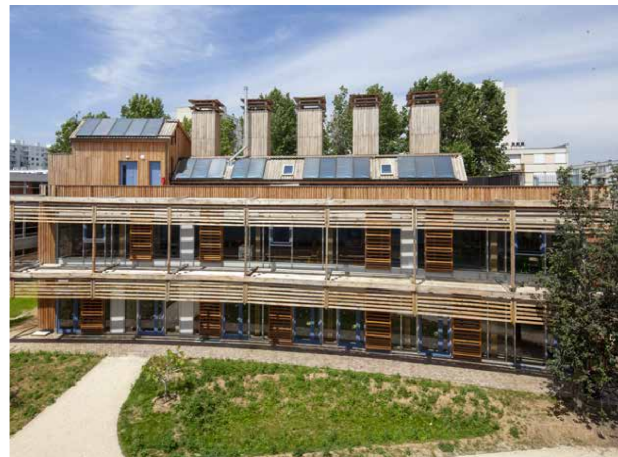
Figure 4: Centre de loisirs Jacques Chirac à Rosny-sous-Bois (France - 93). Bâtiment R+1 recevant du public en paille porteuse (Source : Mairie de Rosny-sous-Bois, © Juan Sépulveda)
