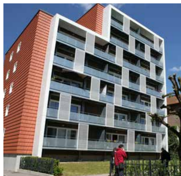
Figure 3: Systèmes de caissons remplis de paille fixés sur une façade en CLT pour l'immeuble Jules-Ferry, à Saint-Dié-des-Vosges. Le Toit Vosgien (Source : Architecte ASP – 18 rue St-Exupéry – 88100 SAINT DIE, BE thermique : TERRANERGIE – 1 Rue du Kemberg – 88100 SAULCY/MEURTHE)
